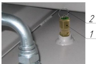
Рисунок 9 – Клапан предохранительный пружинного типа
